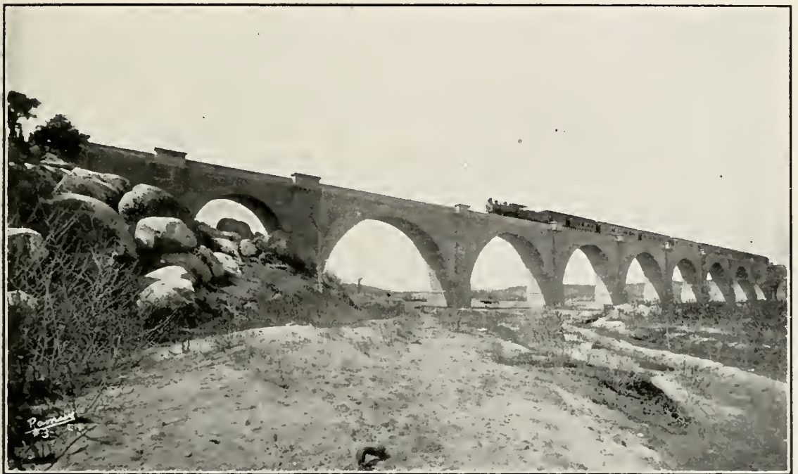
ILL. No. 78. SANTA ANA VIADUCT, ON THE S. P., L. o A. & S. o L. R. R., CROSSING SANTA ANA RIVER, NEAR RIVERSIDE.
